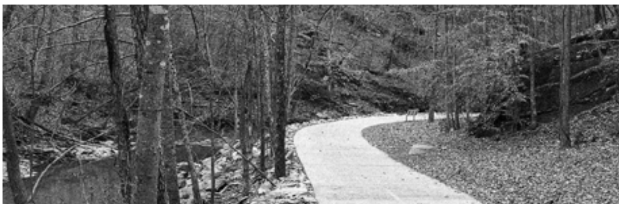
Strada in calcestruzzo permeabile nel parco di Rottenwood, USA
