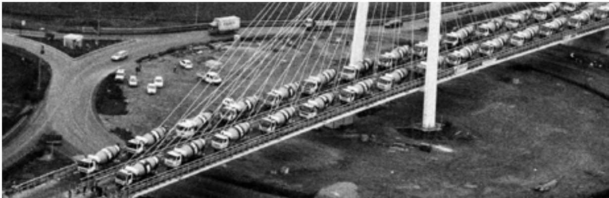
Ponte di Calatrava – Reggio Emilia
